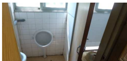
(空き店舗内 5 トイレ)
