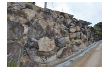
西日本豪雨による崩落から復旧した石垣
